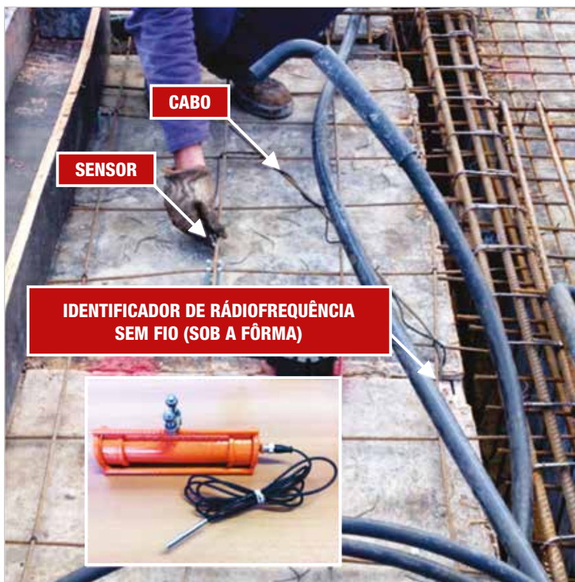
► Figura 1 Instalação dos sensores de temperatura junto à armadura da laje
